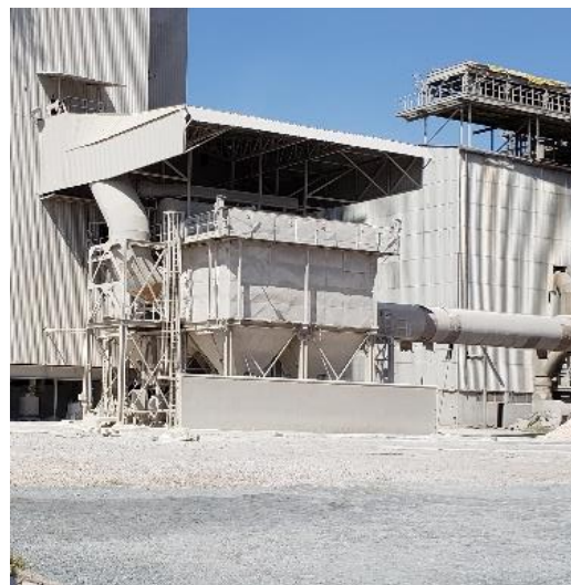
Figura 1.2.1-6 Horno Ausmelt el Sistema de Filtros
