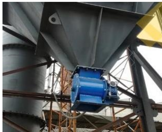
Figura 2.1.11-1 Válvula rotativa
