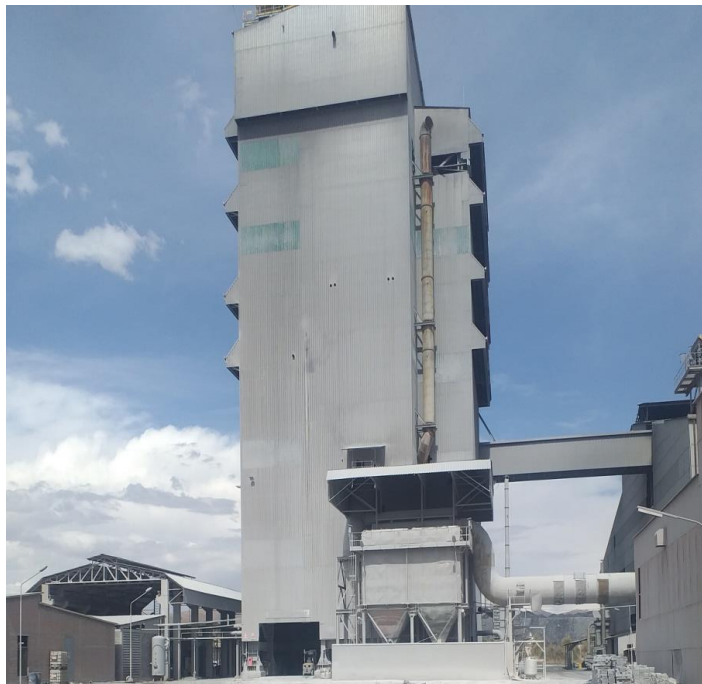
Figura 1.2.1-1 La nave del Horno Ausmelt
