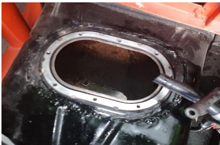
Figura 22. Tanque de gasolina.
