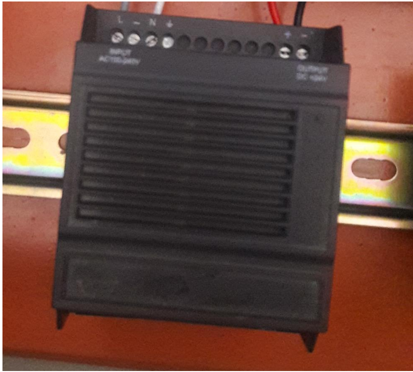
Fig 7 FUENTE DE ALIMENTACION 24 (V) FUENTE PROPIA
