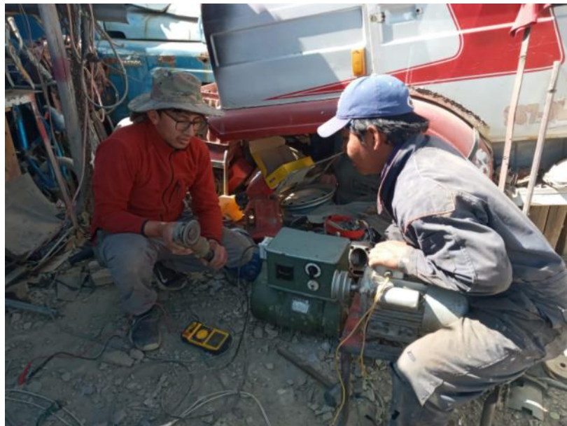
Fig. 10 Toma de datos eléctricos en motores
