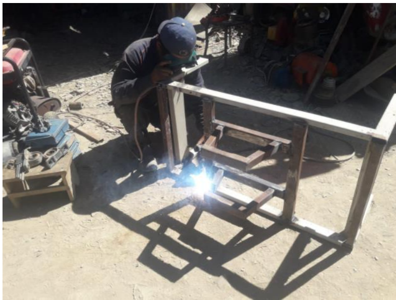
Fig. 06 Preparación de la estructura metálica 3
