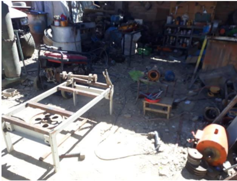
Fig. 04 Preparación de la estructura metálica 1
