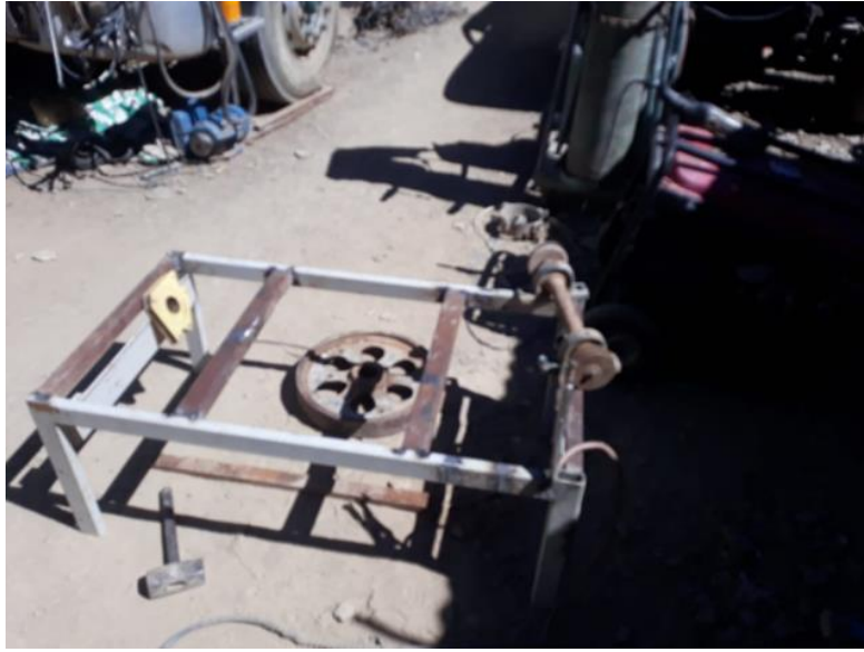
Fig. 05 Preparación de la estructura metálica 2
