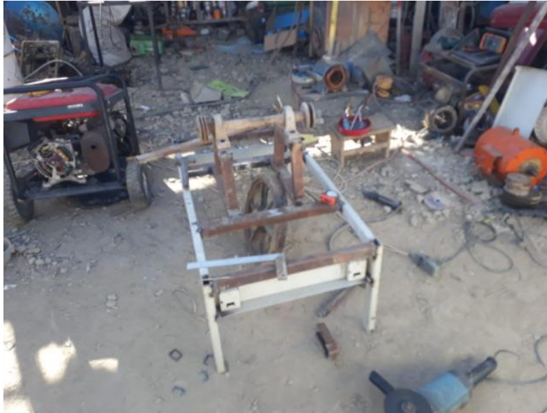
Fig. 07 Preparación de la estructura metálica 4
