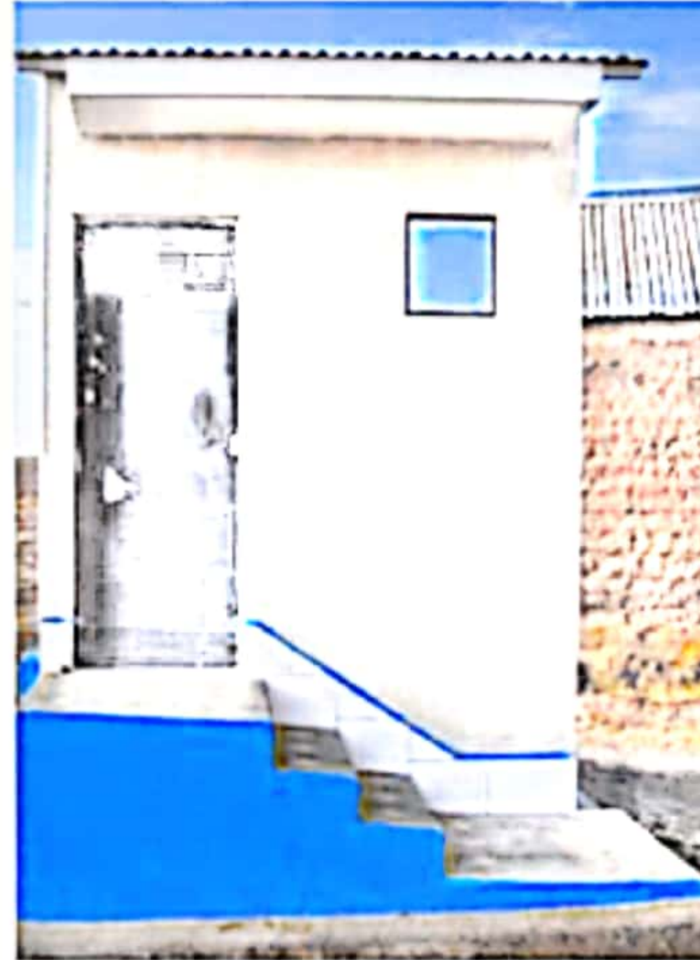
IMAGEN N° 11: ACABADO DEL BAÑO ECOLÓGICO SECO
