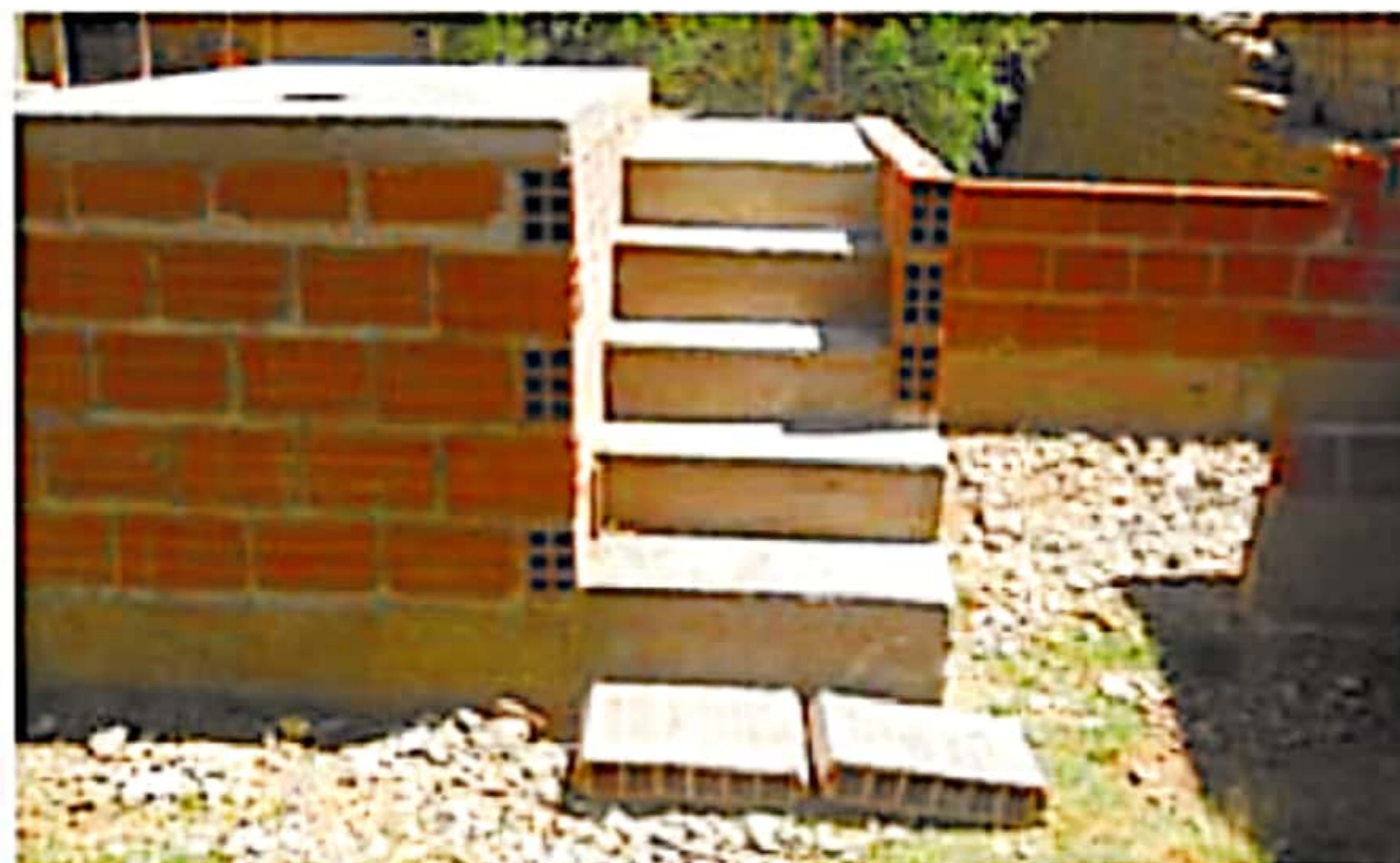
IMAGEN N° 6: GRADAS DE CEMENTO + PIEDRA
