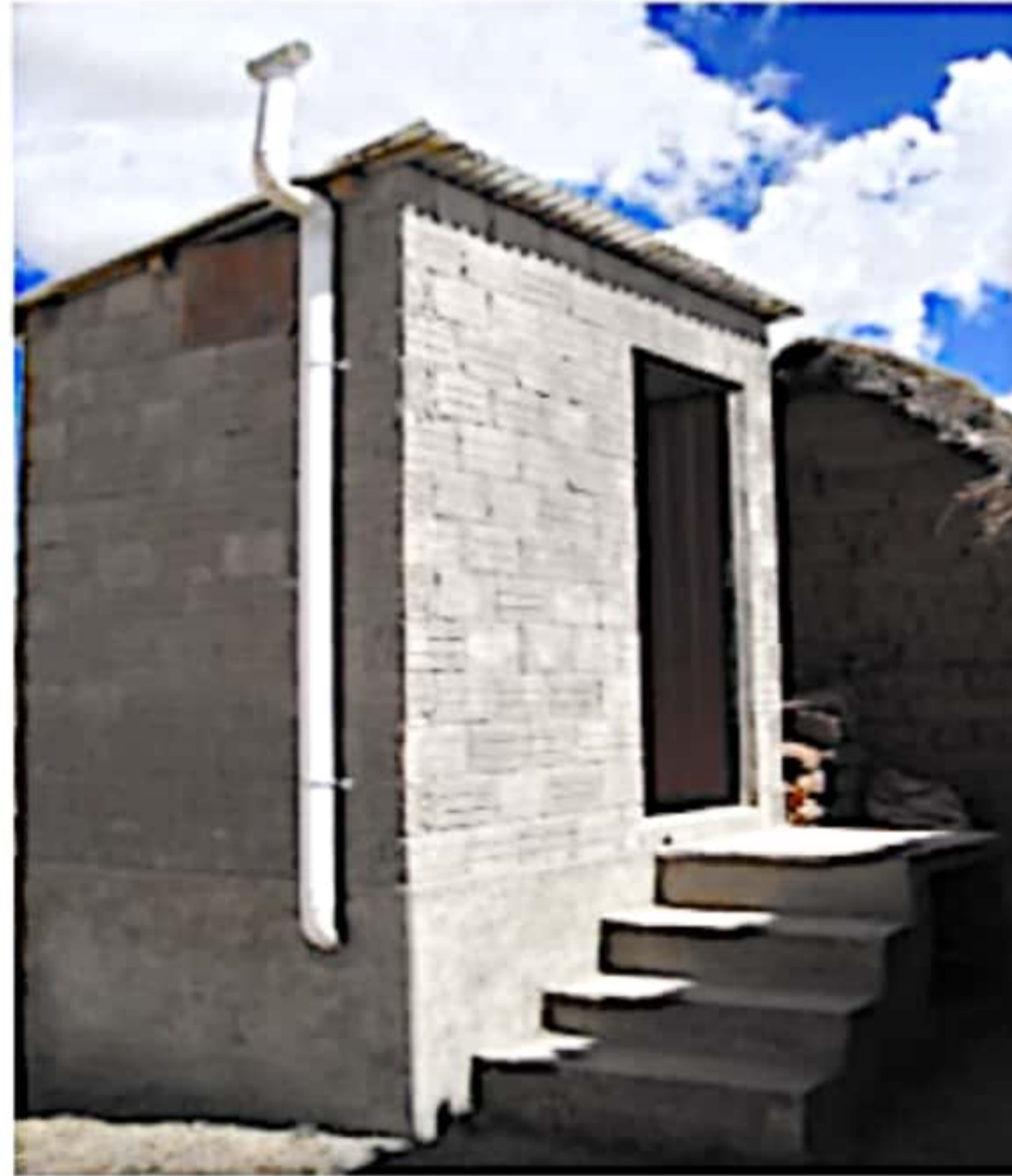
IMAGEN N° 9: VENTILACIÓN SANITARIA
