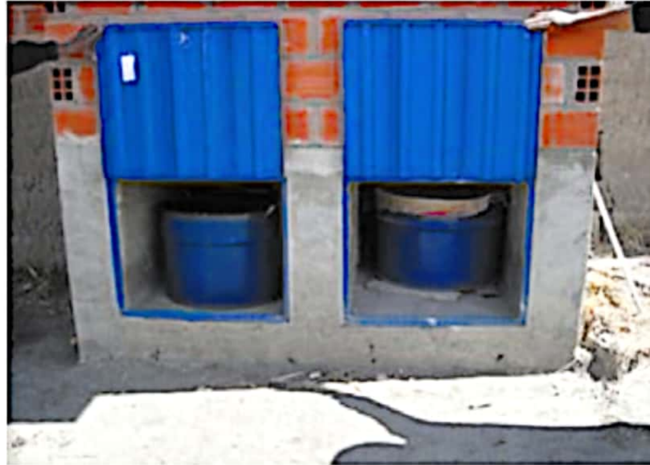
IMAGEN N° 7: COLOCADO DE COMPUERTAS PARA LAS CÁMARAS
