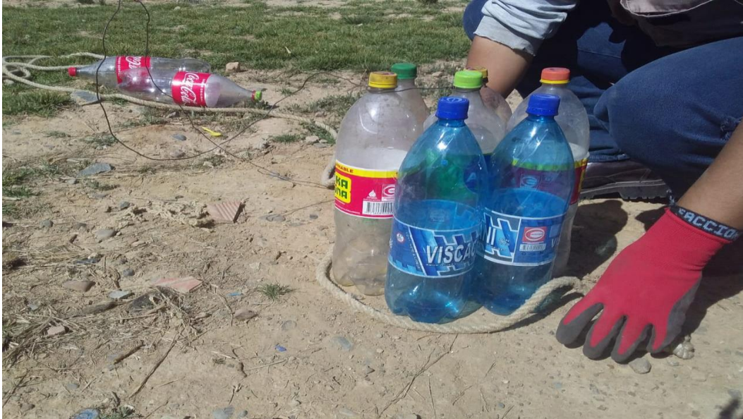
Fotografía 13. Armado de agrupación con las botellas para la biobardas
