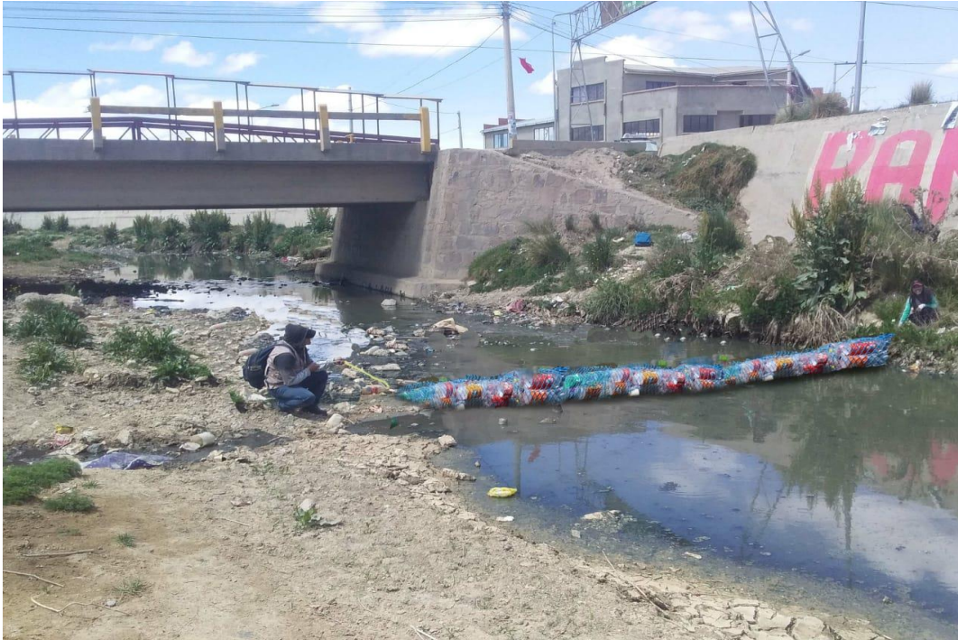
Fotografía 15. Instalación de la biobardas en el Río Pallina
