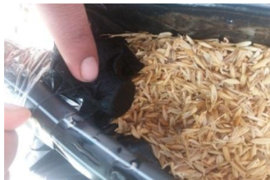
FOTOGRAFIA 18. Colocado de tela en los tubos de drenaje
