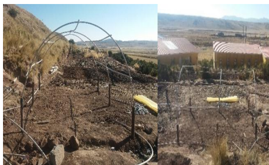
FOTOGRAFIA 29. Colocado de los arcos del macro túnel
