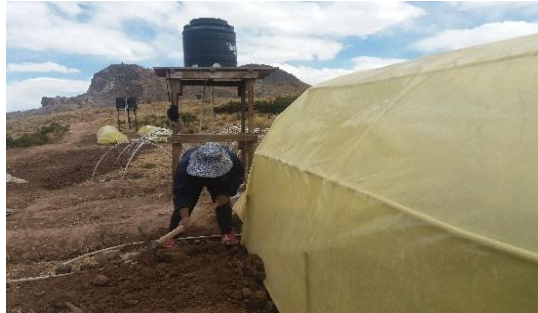
FOTOGRAFIA 31. Tapado de las laterales para la sujeción del Agrofilm
