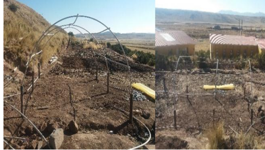
FOTOGRAFIA 5. Colocado de los arcos del macro túnel
