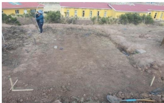
FOTOGRAFIA 1. Replanteo y trazado de terreno
