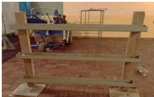
FOTOGRAFIA 36. Construcción y armado de la estructura vertical
