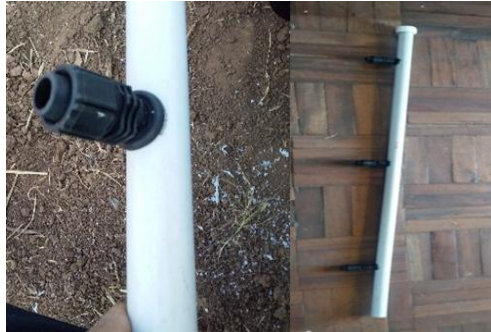
FOTOGRAFIA 16. Colocado de conectores para la cinta de riego
