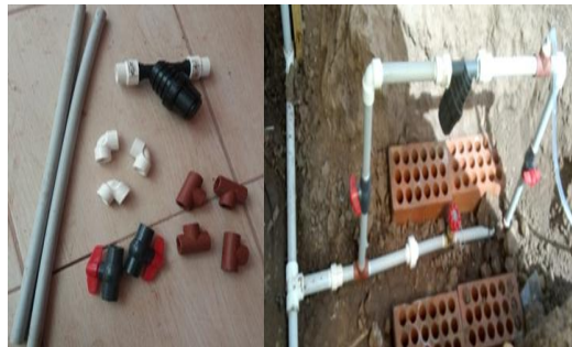
FOTOGRAFIA 11. Componentes del equipo de riego y sistema Venturi
