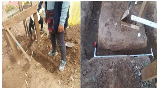
FOTOGRAFIA 33. Tubería principal de salida de agua del tanque
