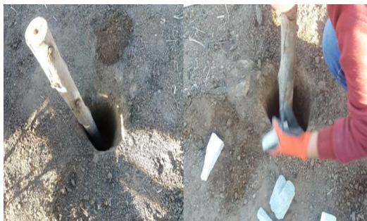
FOTOGRAFIA 28. Colocado de las estacas
