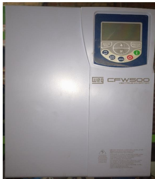
FIGURA N°29: Variador de frecuencia
